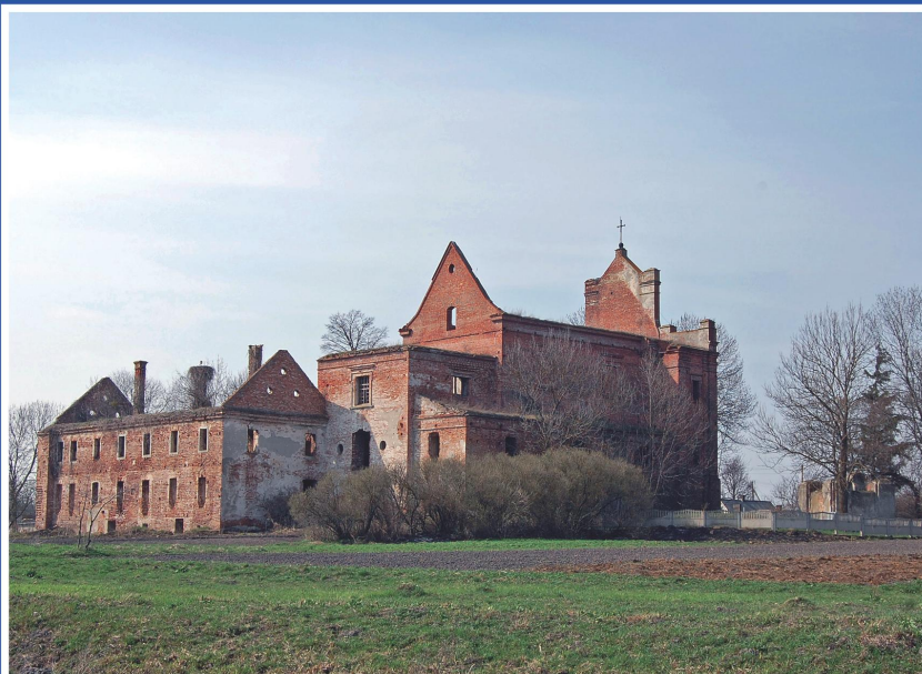
Kisielin – ruiny kościoła pw. Niepokalanego Poczęcia Najświętszej Marii Panny i plebanii (fot. 2019 r.)
