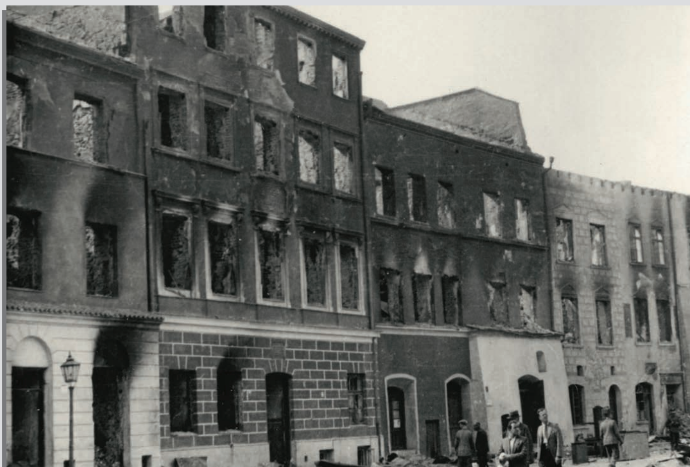
↑ Zniszczone kamienice, ul. Rynek, Stare Miasto w Lublinie
