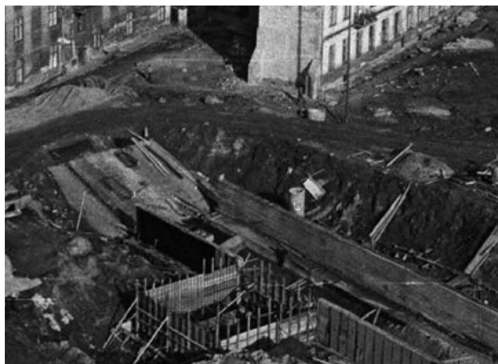
Przejście podziemne u zbiegu ulic Kilińskiego i Traugutta, jeszcze w budowie (Muzeum Tradycji Niepodległościowych w Łodzi)
