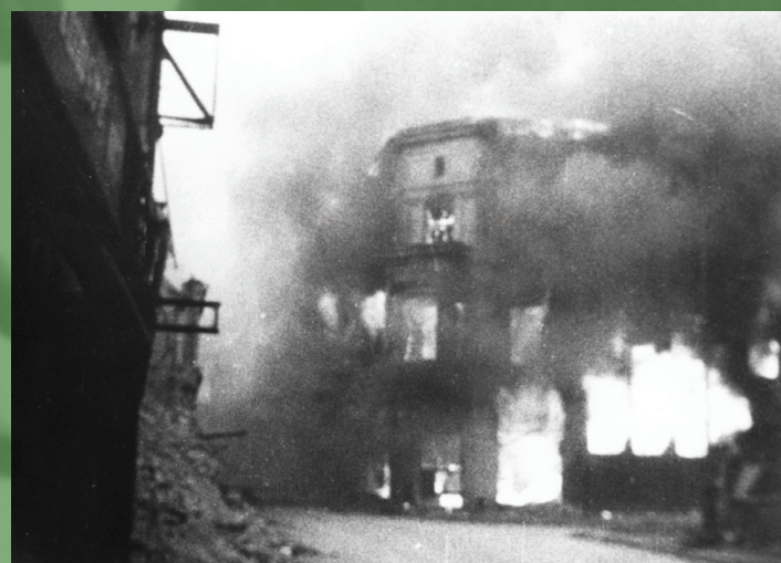
Racibórz, który został zajęty przez Sowietów 31 marca 1945 r., w wyniku walk oraz późniejszych dewastacji i rozbiórek utracił ok. 80 proc. stanu zabudowy. Na zdjęciu płonące kamienice w Raciborzu (ze zbiorów AP w Opolu)
