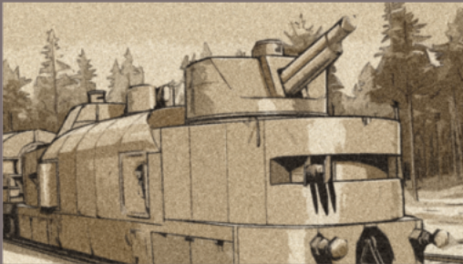
Rysunek 1. Jeden z nowych wagonów artyleryjskich „Śmiałego” z widocznymi wysuwanymi drzwiami i umieszczonymi w nich ciężkimi karabinami maszynowymi – sierpień 1939 rok.
