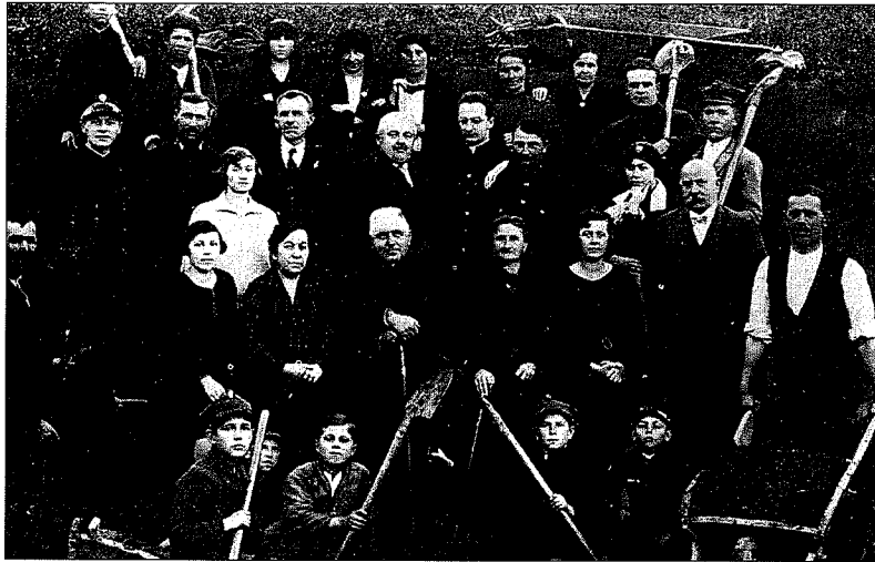
Zbigniew Cichobłaziński (siedzi z łopataą drugi od prawej) podczas przerwy przy budowie polskiego Domu Katolickiego w Żurawicy
