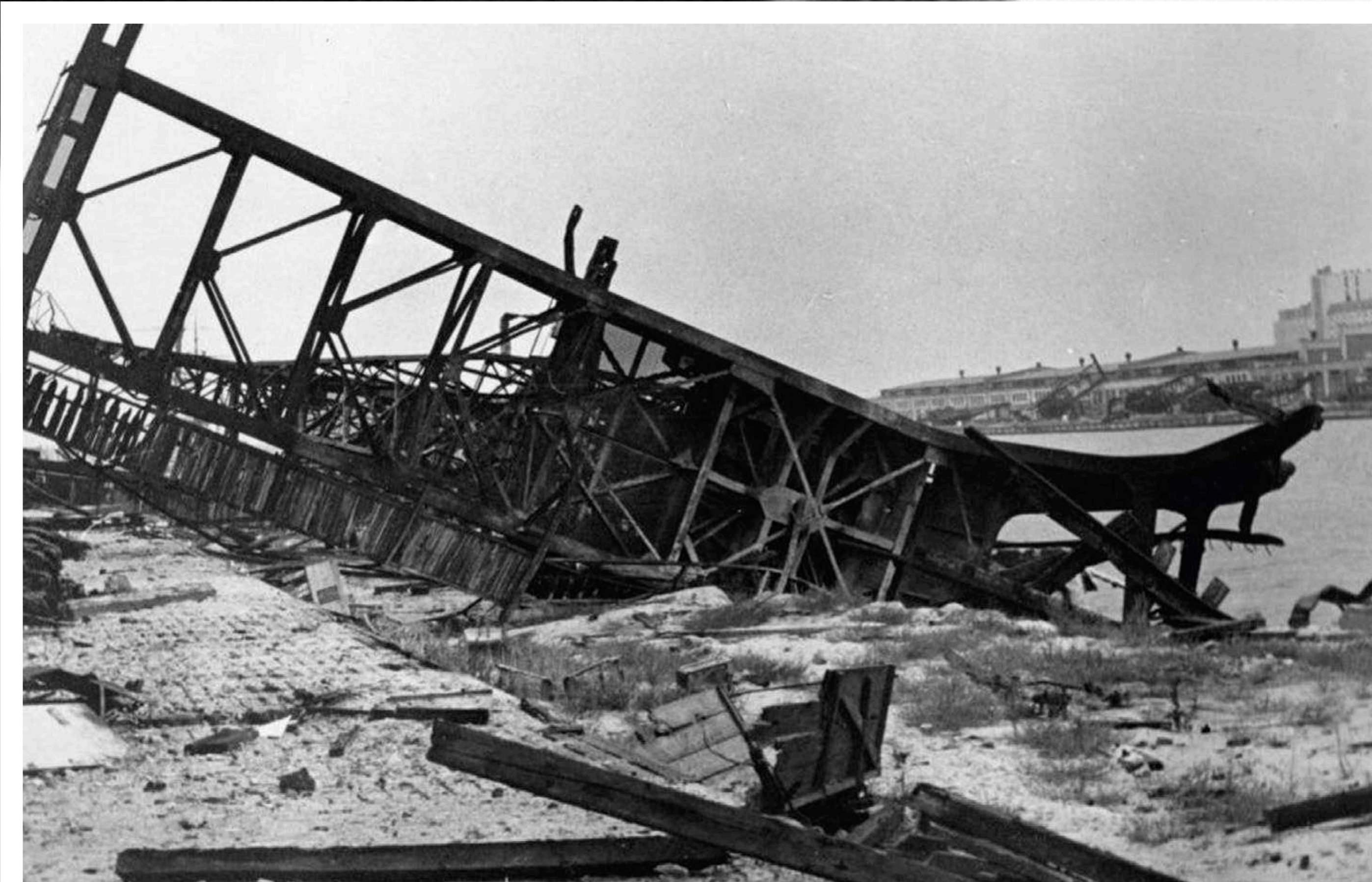
Zniszczone urządzenia przeładunkowe Nabrzeża Rumuńskiego w gdyńskim porcie (APG).
