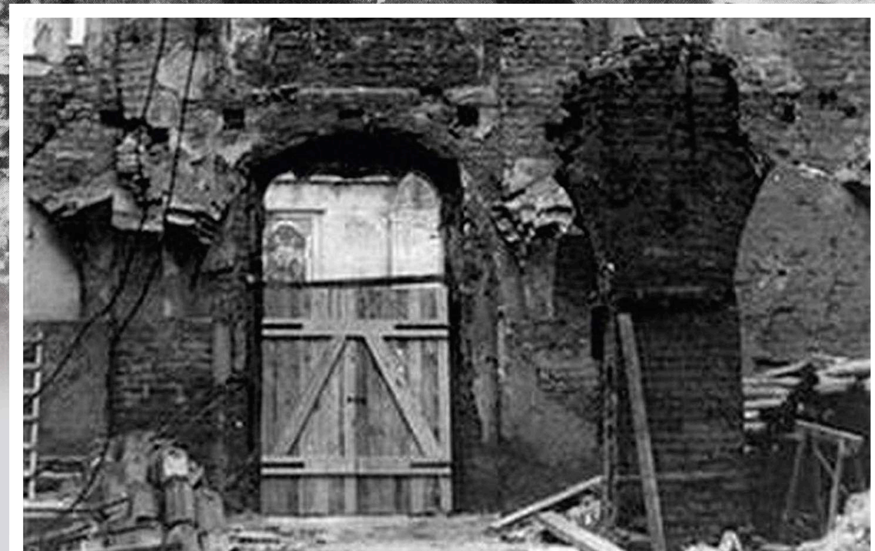
Widoczne uszkodzenia wewnątrz kościoła od strony drzwi wejściowych, 1945 rok (Archiwum parafii św. Józefa w Gdańsku).
