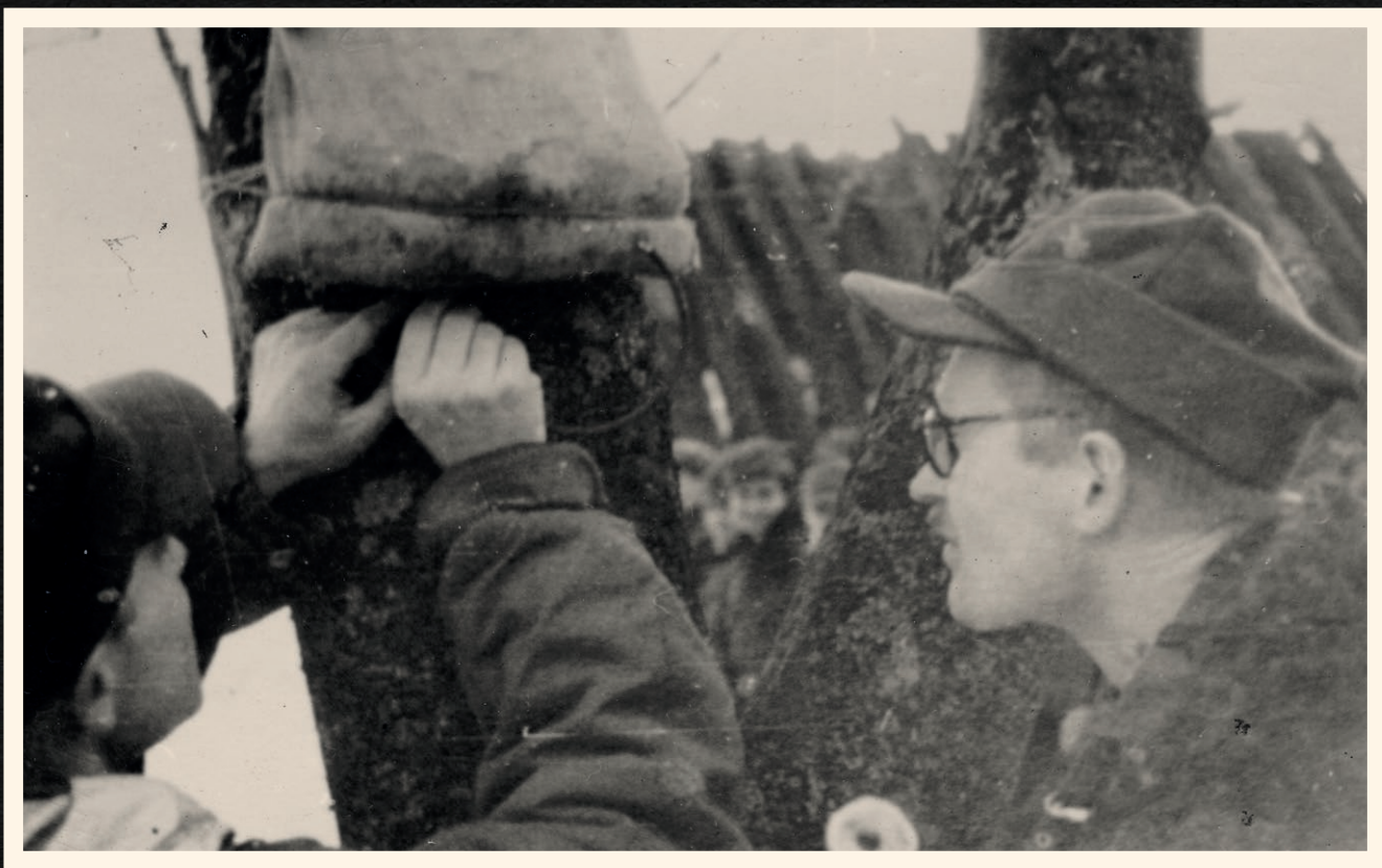
Porucznik cc. Piotr Motylewicz „Szczepcio” prezentuje ppor. Henrykowi Meszczyńskiemu „Dziewicowi” (z prawej) metody montowania ładunków wybuchowych. Obaj oficerowie służyli w 6. Wileńskiej Brygadzie AK. Ładunek, który przytwierdzono do drzewa po odpaleniu rozerwał pień i wyrzucił mnóstwo drzazg, które (na szczęście niegroźnie) zraniły kilku, obserwujących pokaz, partyzantów. Wileńszczyzna, Buniany, 7 I 1944 r.
