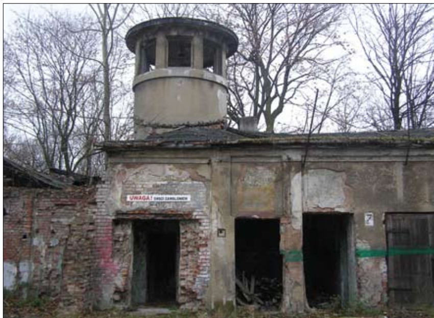
Budynek łaźni więziennej (obecnie już nie istniejący).
