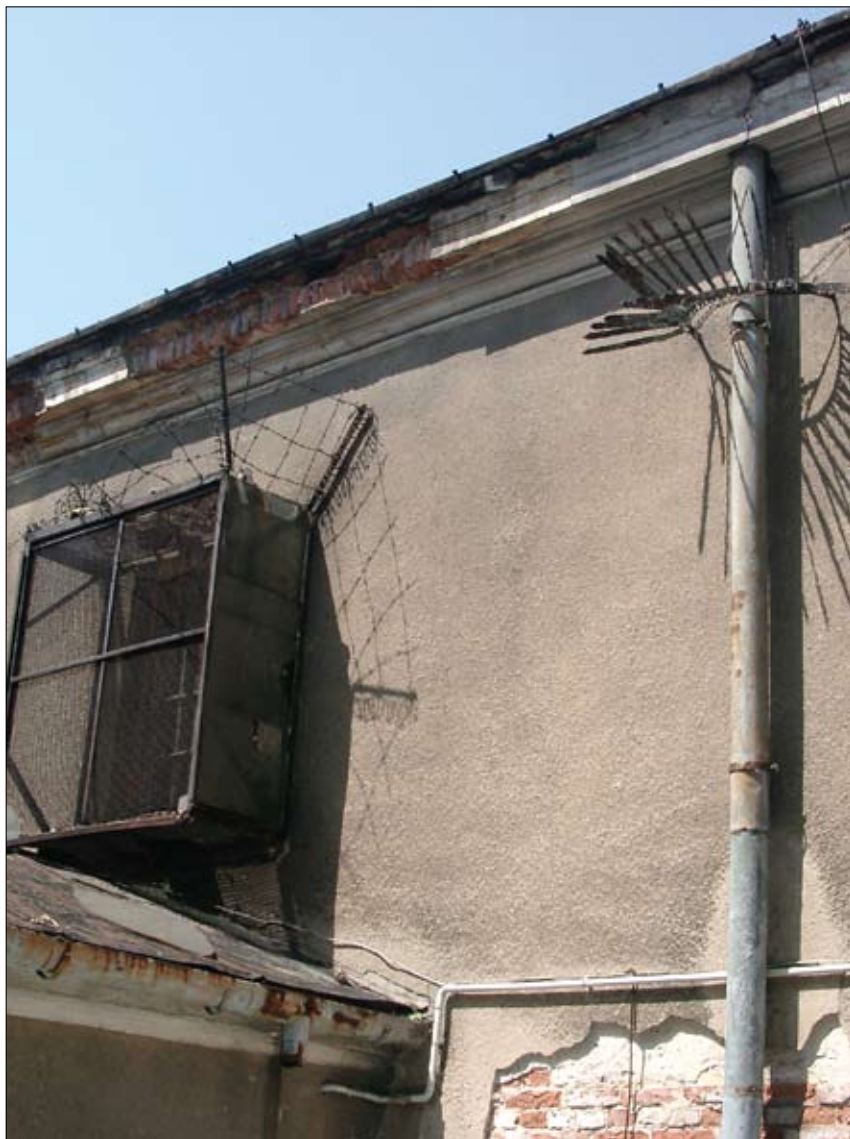
Zabezpieczenia (druty kolczaste) w oknach cel i na rynnach skrzydła wschodniego więzienia kieleckiego (stan obecny).
