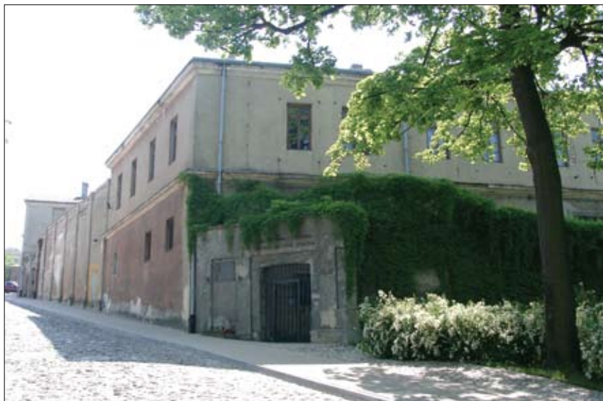
Kompleks więzienny w Kielcach (północna elewacja) od strony ul. Zamkowej (stan obecny).
