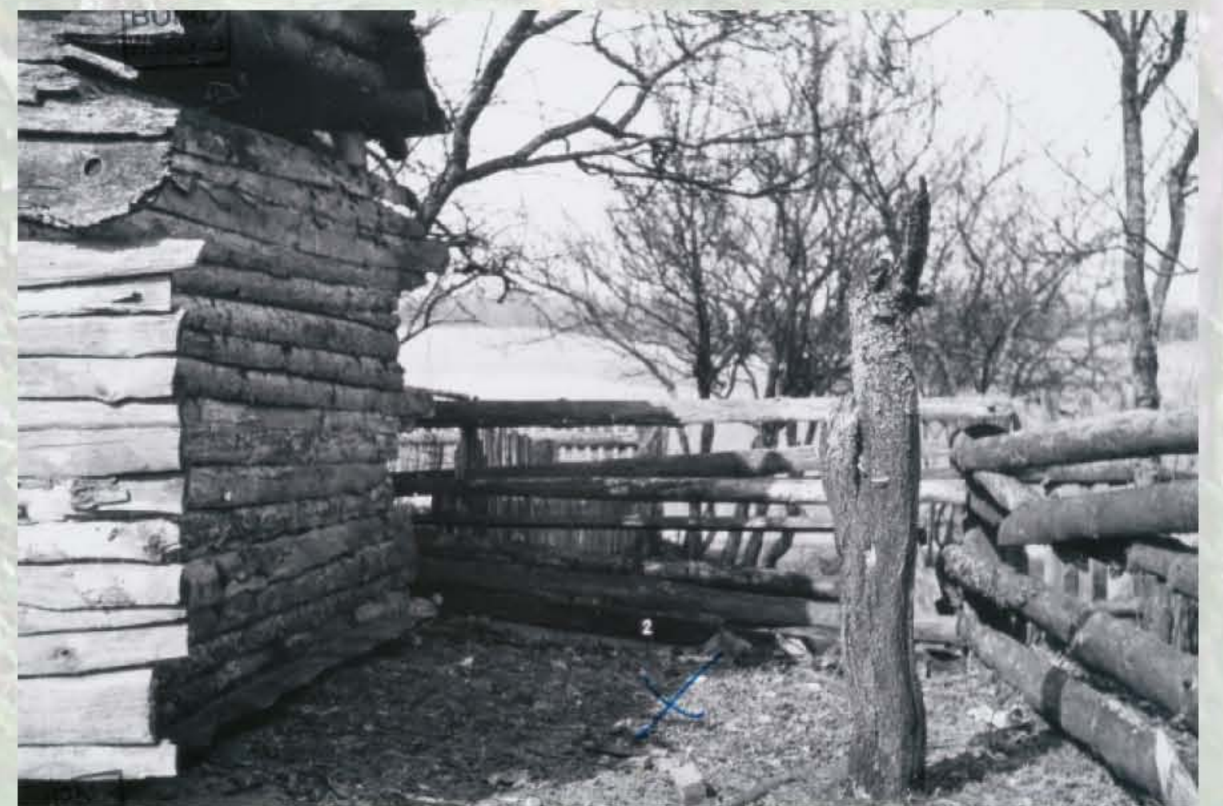
Zamaskowane wejście do bunkra TOW „Gryf Pomorski” w Kamienicy Królewskiej (Archiwum IPN, dalej: AIPN)
