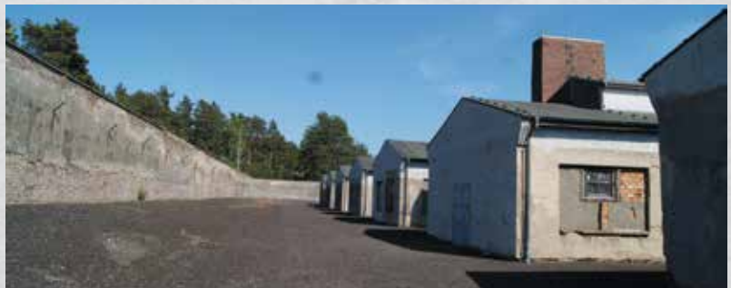
Obóz otoczony był czterometrowym murem dodatkowo zabezpieczonym drutami pod prądem wysokiego napięcia. Fot.: Urszula Gierasimiuk
