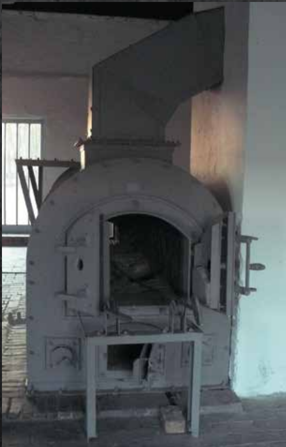
Dodatkowy piec krematoryjny zainstalowany pod koniec 1944 r. Fot.: Ewelina Małachowska
