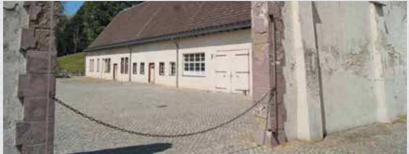
Brama obozowa (widok z wnętrza obozu). W tle zabudowania zajmowane przez załogę SS. Fot.: Ewelina Małachowska
