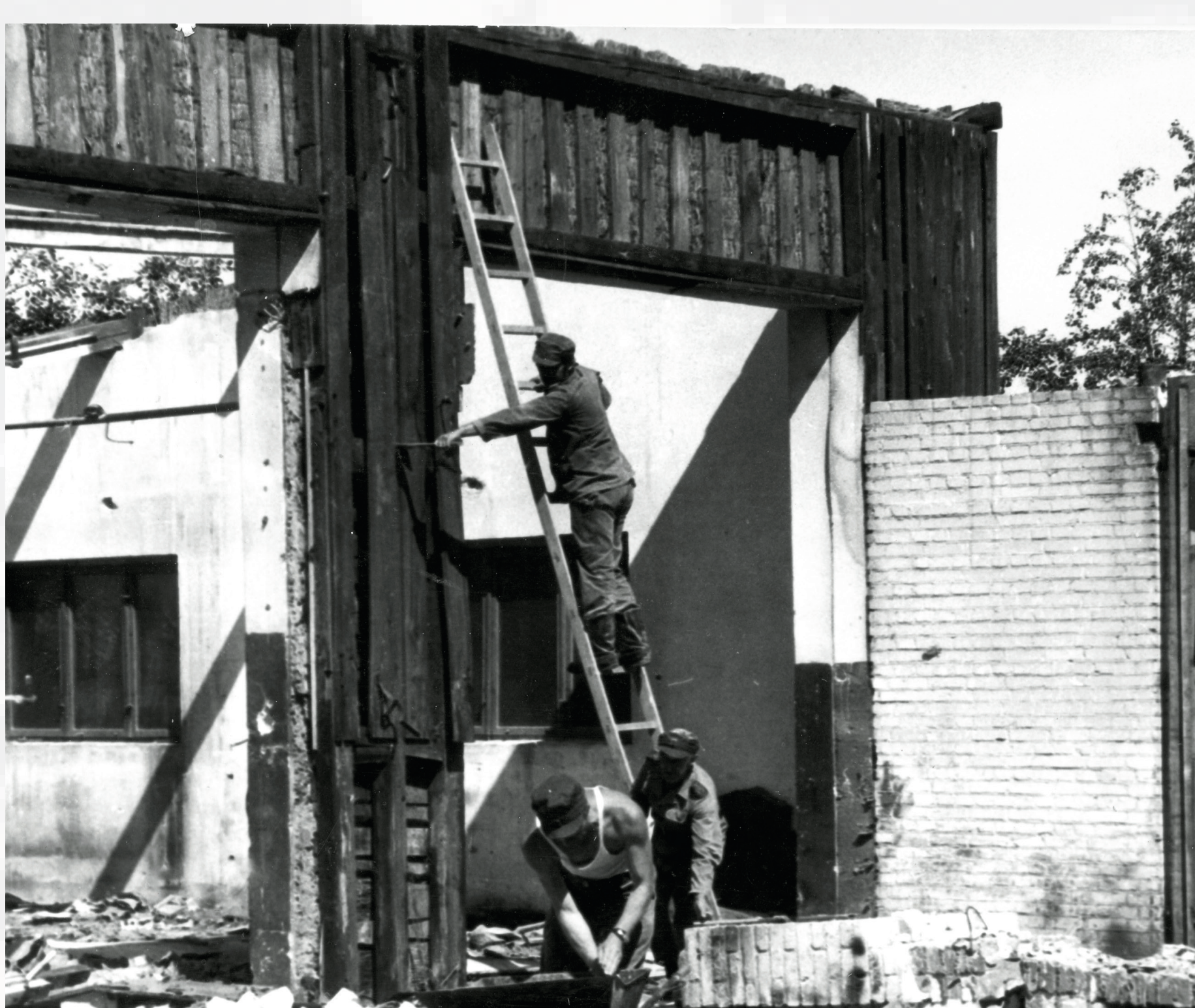
Usuwanie przez strażaków szkód spowodowanych pożarem. Fot. PSP w Siemiatyczach
