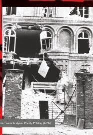
Zniszczone wnętrze budynku Poczty Polskiej (APN)
